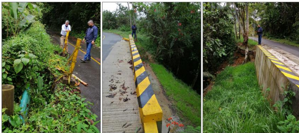
Visita a la vía Carniceros (Pijao - Córdoba). Evaluación y monitoreo de la estabilidad del sector y las obras ingenieriles realizadas para la recuperación de la vía. Noviembre 11 de 2020.
