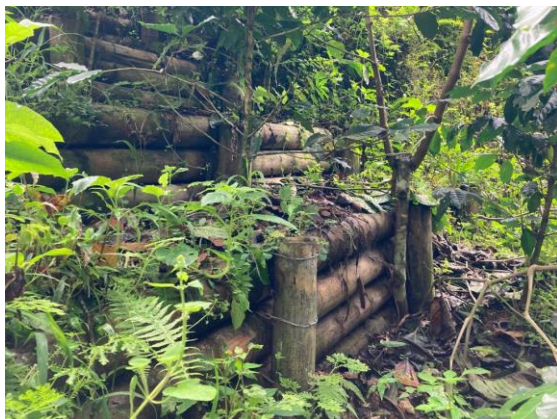
Seguimiento temporada de lluvias sector Elba roja trinchos construidos por la CRQ en la vereda Travesías municipio de Calarcá 12 de noviembre de 2020
