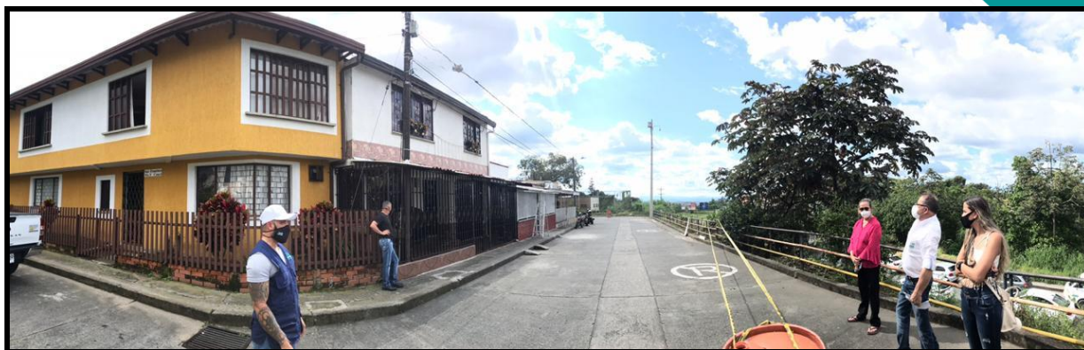
Visita técnica necesidad de muro de contención - Barrio San Francisco, Municipio de Armenia.
